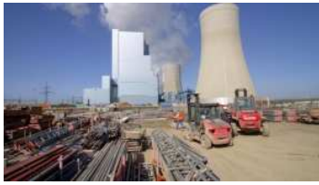
© EDGAR R. SCHOEPAL 90.000 Tonnen Stahl: Am Kraftwerk Neurath II wird weiter kräftig gebaut
